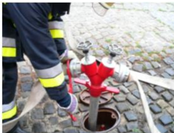
113. kép: tömlő kapcsolása állványcsőre
